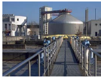
Kläranlage mit Faulturm – Vertiefung Infrastruktur
