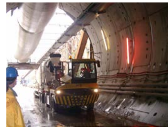
Tunnelbau – ein Schwerpunkt im Konstruktiven Ingenieurbau
